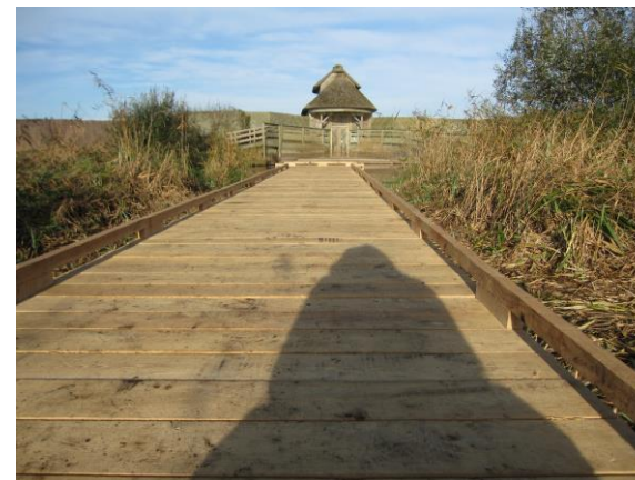
En cours de construction
